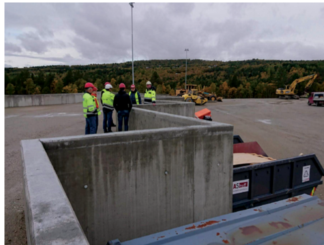
Befaring under bygging av ny gjenvinningsstasjon på Røros. Daglig leder Jan Otto viser representanter fra kommunen rundt i oktober.
